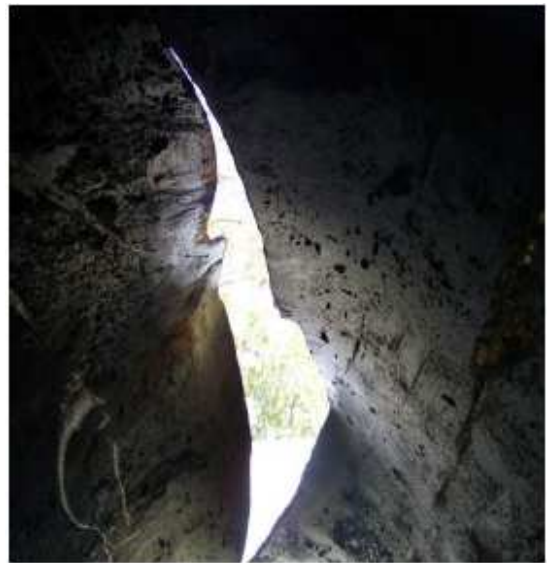
Foto N° 2: Vista interior de la tubería.
